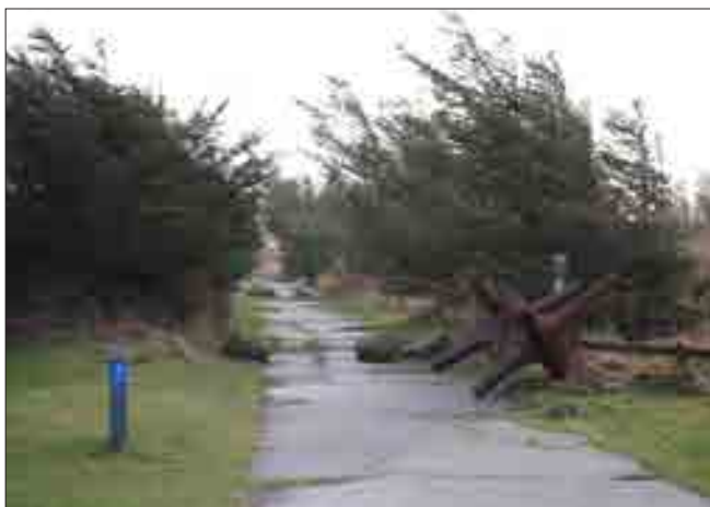
Betonvej med tjekkiske pindsvin
