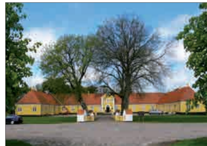
Hovedbygning med indbyggede hundehuse ved adgangen over voldgraven
